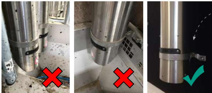
Mettez d'abord la dernière fixation du bas en place sur le bas-flanc du Feedstation. Faites glisser en suite le PipeFeeder dedans.
